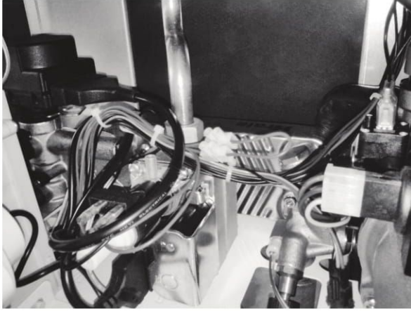
рис. 7 – Доступ к клеммной панели
